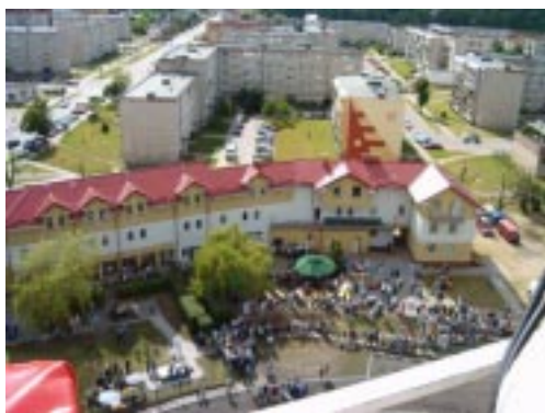
Budynek i zaplecze MOKSiR
